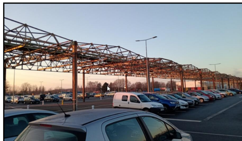
Photo 1A : Liaison bâtiment 2 vers ancien parking bâtiment 1 (Source : ACC)
