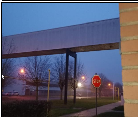
Photo 2A : Haut : Liaison bâtiment 6 vers bâtiment 5 ; Bas : Liaison bâtiment 4 vers bâtiment 3 (Source : ACC)
